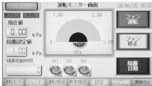
タッチパネル式運転モニター
