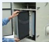
フィルター押さえの蝶ナットを緩めて フィルターを取り出して下さい。
